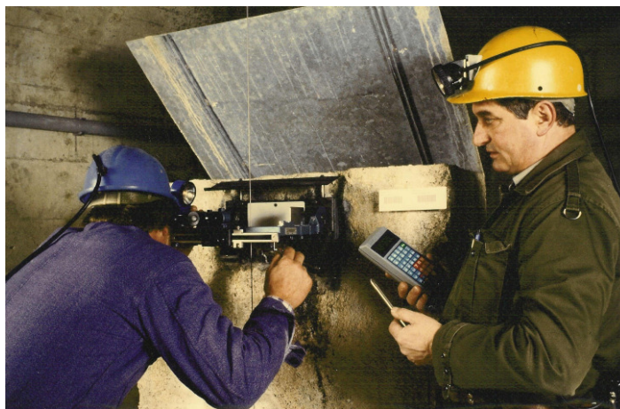
Mesure de déformation par pendule dans une galerie d'un barrage. (Source: Emosson SA)
