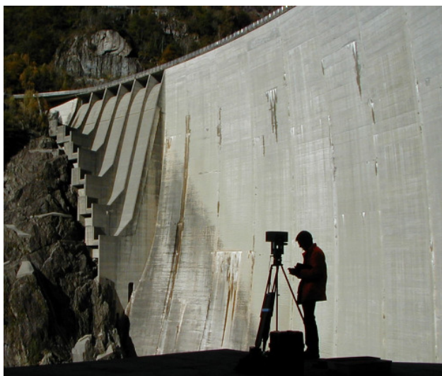
Mesures géodésiques au barrage-voûte de Contra (Source. Schneider Ingénieurs SA, Coire)
