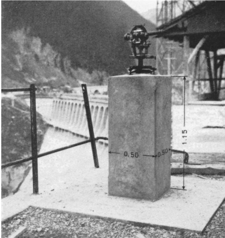
Abb. 8: Beobachtungspfeiler III im Netz der Staumauer «Schräh»; Einachsertheodolit von Hildebrand mit 21 cm Kreisdurchmesser (Lang 1929)
