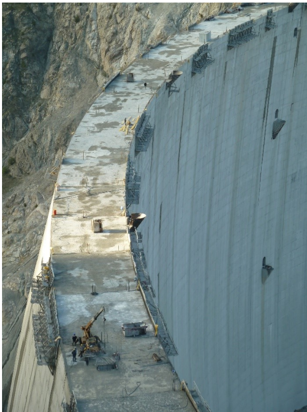
Abb. 44/45: Staumauer «Deriner», Türkei, vor der Fertigstellung der Mauerkrone auf Höhe 250 m; gut sichtbar sind die grossen Schalungen für die Balkone; vgl. auch Abb. 63 (Pöry Schweiz AG)
