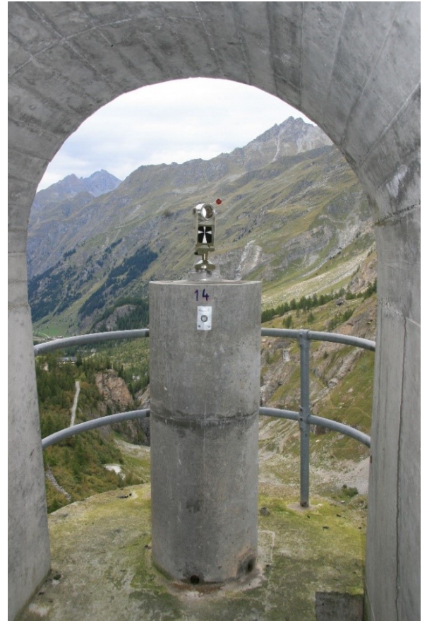
Abb. 43: Kombinierte Reflektor-Zielmarke (Kern ME3000), Staumauer «Mauvoisin» (Pöry Schweiz AG)
