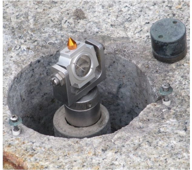
Abb. 56: Kern Kleinreflektor in Kappenbolzen auf der Staumauer «In den Schlagen», Sihlsee (swisstopo 2014)
