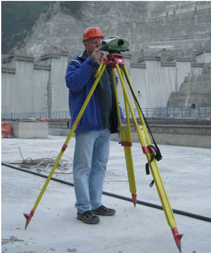
Abb. 46: Nivellement mit Leica Digitalnivellier DNA03 beim Bau der Staumauer «Deriner», Türkei (Pöryr Schweiz AG)
