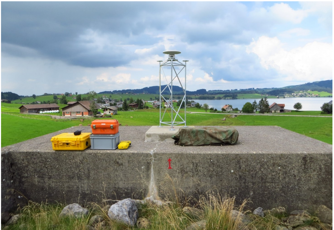
Abb. 27: GPS-Station (Trimble 5700/Zephyr) auf einem externen Referenzpunkt (LV95-Punkt Einsiedeln) für die Staumauer «In den Schlägen» am Sihlsee (swisstopo 2014)
