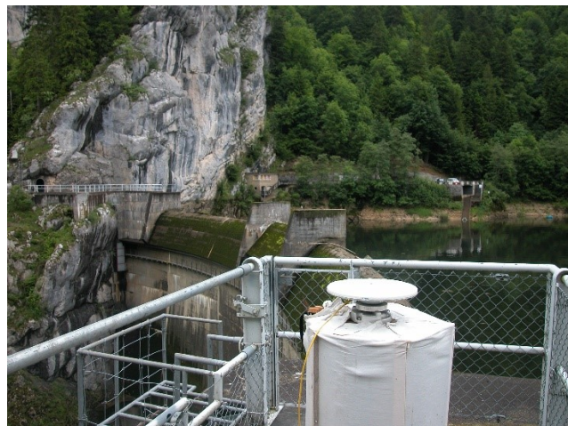
Abb. 76: GPS-Antenne Trimble 5700/Zephyr Staumauer «Châtelot» (swisstopo 2008)
