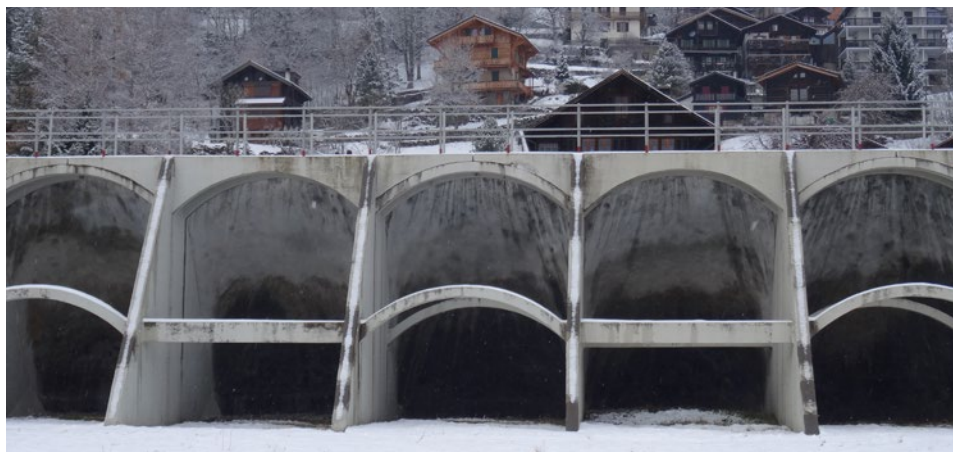
Frontalansicht des Ausgleichsbeckens im November 2017.
