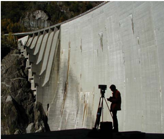
Geodätische Messung an der Bogenmauer Contra (Quelle: Schneider Ingenieure AG, Chur)
