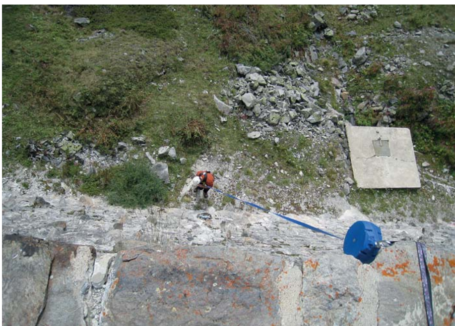
Figura 4. Controllo dei dintorni dello sbarramento.
