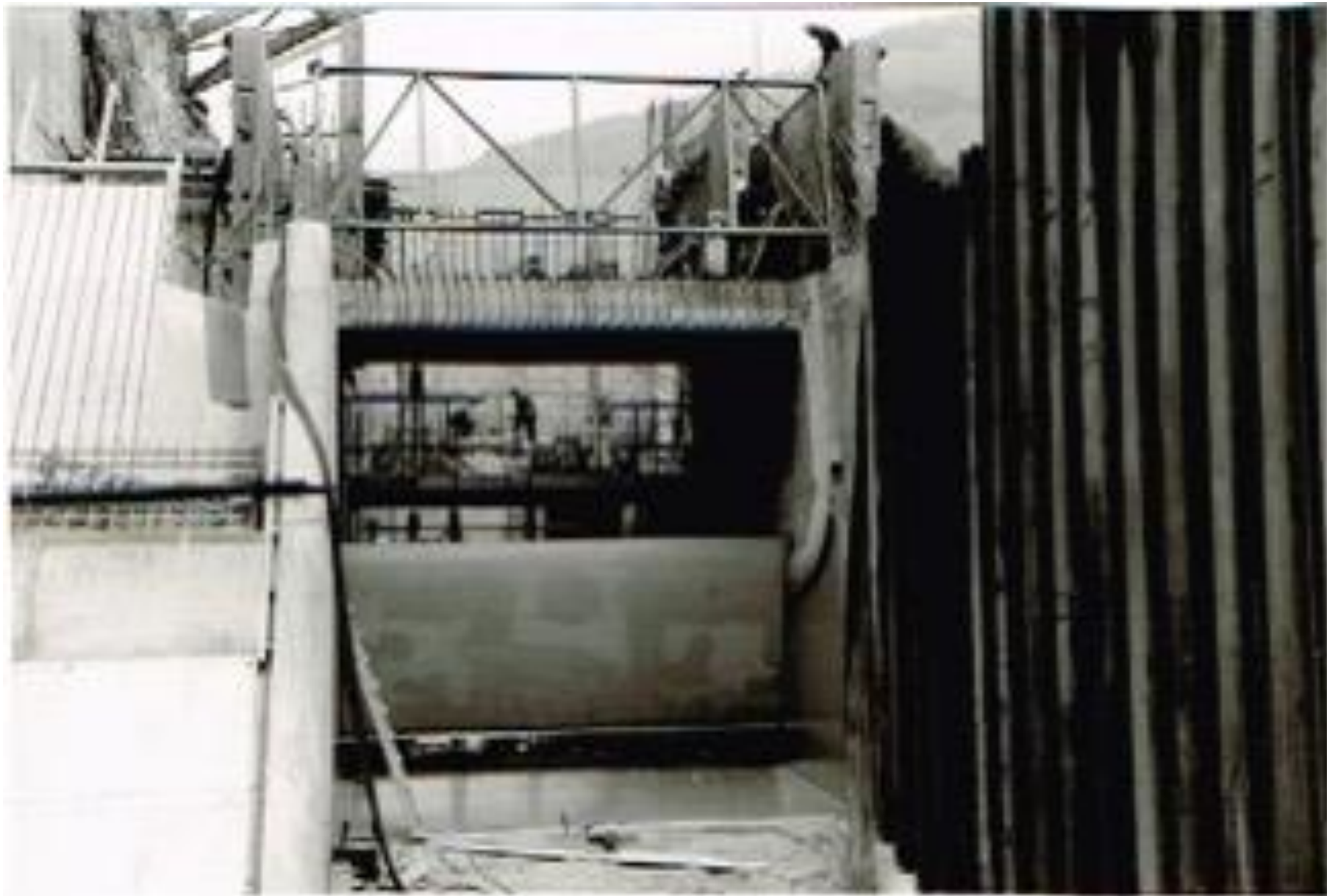
Montage de la vanne secteur de la vidange de fond
