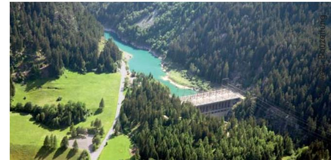
Die Stufe Bärenburg ist die zweite von drei Stufen der Anlagen im Gebiet der KHR und wurde in den Jahren 1959–1960 erbaut. Das Kraftwerk ist für eine Ausbaumassmenge von  $80 \text{ m}^3/\text{s}$  ausgelegt. Das turbinierete Wasser gelangt direkt in den Stausee Bärenburg. Sowohl die Zentrale wie auch die Freiluftschaltanlage und die Staumauer Bärenburg sind in einem einzigen Bauwerk untergebracht.
