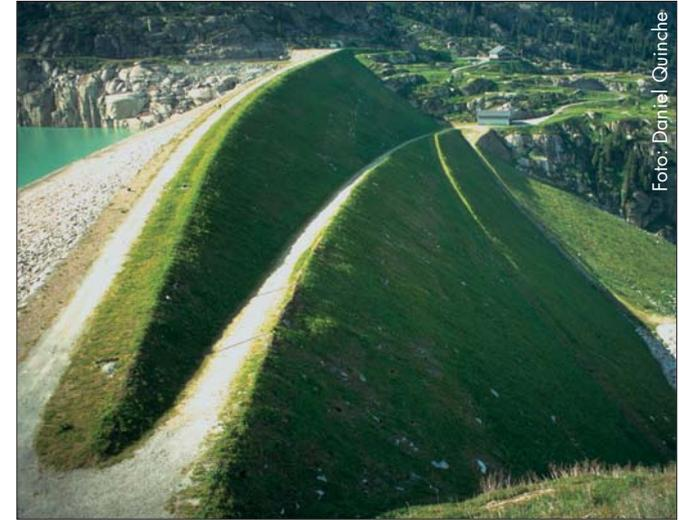
Der Göscheneralpdam ist noch heute einer der grössten Staudämme in Europa. Er besteht aus Erd- und Steinmaterial, welches im Tal selbst abgebaut wurde. Seine Dichtigkeit verdankt er dem vertikalen zentralen Kern aus Erdmaterial, dem 10% Ton beigemischt worden ist. Heute zeigt der Damm ein elastisches Verhalten, mit Schwankungen infolge Wasserlast von rund 40 mm pro Jahr. Gleichzeitig setzen sich die Kronenpunkte noch mit etwa 4 mm pro Jahr.
