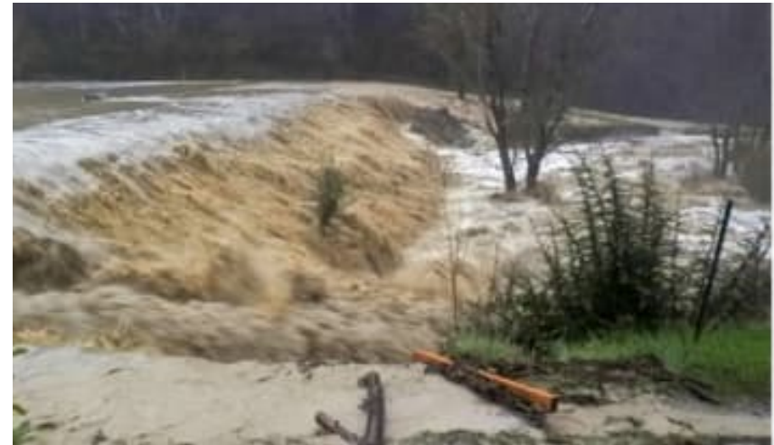
Überströmen des Chalabre Damm (FERC, January 2020)
