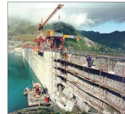
Assainissement du Parement amont
